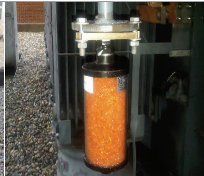
Nouvel assécheur R1 avec bride DIN 42562 flange.
